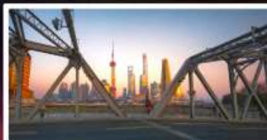
สะพานไวปี้ตู่
